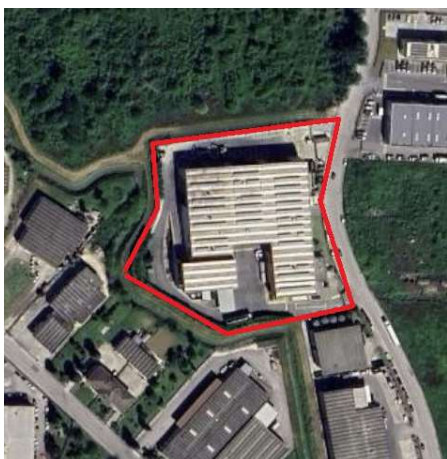
Foto satellitare dell'impianto (evidenziato in rosso)
