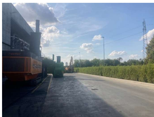
Strada perimetrale Nord
