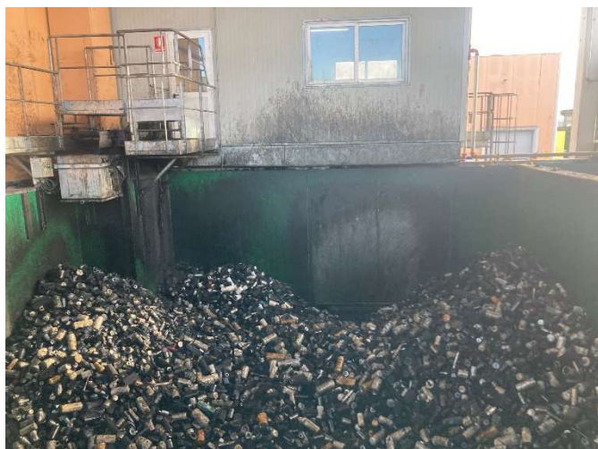
Area G, trattamento filtri olio
