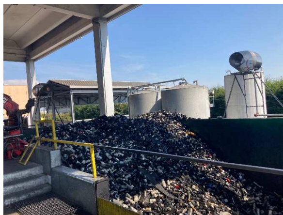
Area G, trattamento filtri olio
